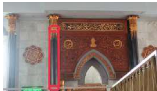
Gambar 19 Tiang Penyangga Masjid
